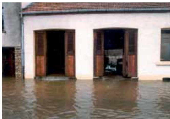
▲ rue des Pâquis à Lamorteau, inondation du Ton. Photo G. Vandenende
